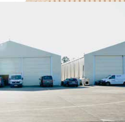
Neu und alt im Vergleich: vorne links der aufgebauete 4-Container-Verbund, rechts dahinter der 2-Container-Verbund
