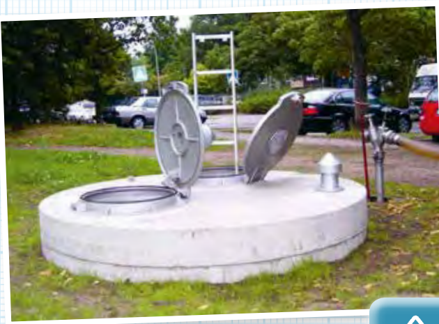
Trinkwassernotbrunnen in Hamburg.
